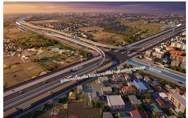
รูปที่ 5 รูปแบบทางเลือกที่ 2 สะพานข้ามแยกเลี้ยวขวา (Direction Ramp) รองรับรถเลี้ยวขวา
